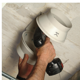
Fissaggio del supporto.
